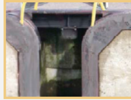
Vue des renforcements de bollards flottants avec des pièces de transition (moulées) pour la protection des bords horizontaux (sur demande).
